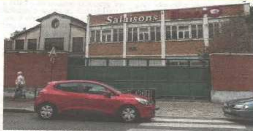
Le Pré-Saint-Gervais, fin juin. Les anciennes salaisons Busso, fermées en 2012, devraient être rasées pour laisser place à un gymnase et 140 logements. (LP/AL)
